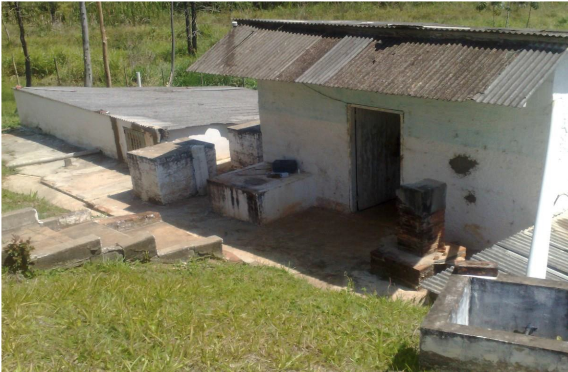
Foto: 27 – Visão lateral da casa das bombas e de 01(um) dos reservatórios semi-enterrado (nº. 2) – Capacidade de 25m 3 .
