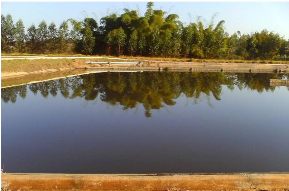
Foto: 58 - Visão-IV - Vista parcial da 2ª lagoa de tratamento (facultativa)
