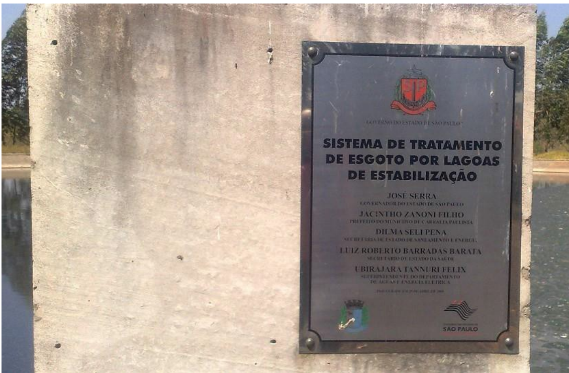
Foto: 48 – Placa que simboliza a conclusão da obra – Lagoas de tratamento
