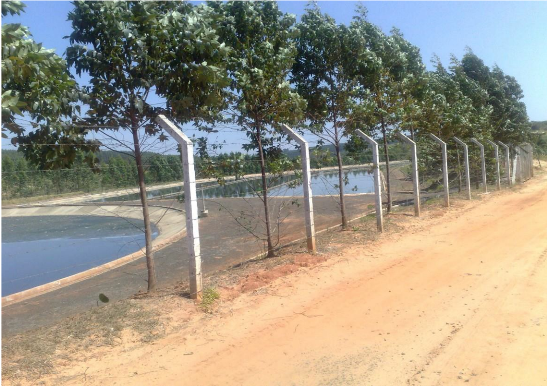
Foto: 59 - Visão externa do local onde se encontra a Estação de tratamento de Esgoto
