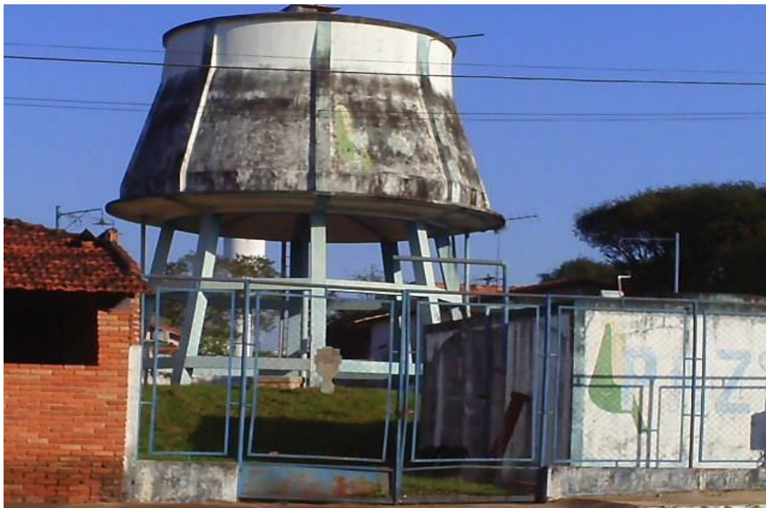
Foto: 06 – Reservatório Elevado Central - Capacidade de 360m 3 - Localização: Rua Manoel Francisco - Centro
