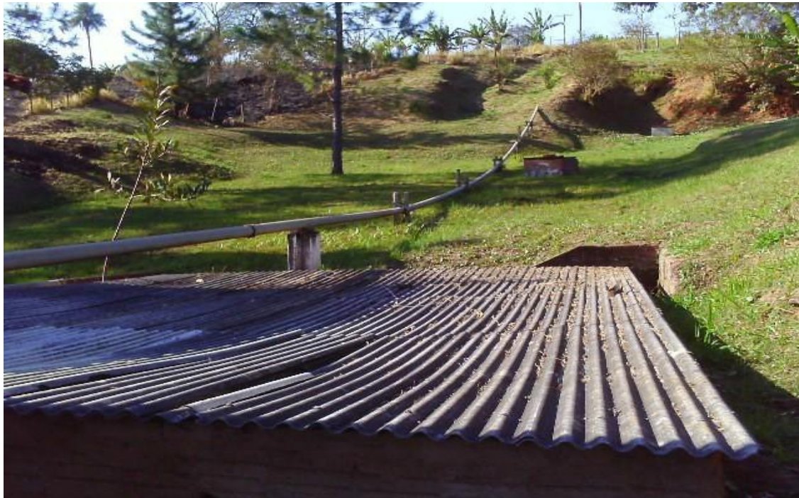
Foto: 23 – Reservatório semienterrado nº 1 – Capacidade de 25m 3 - Recebe água das minas, e após o tratamento é recalçada para os reservatórios da cidade.
