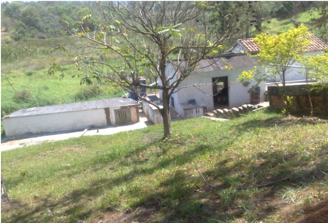
Foto: 25 – Visão externa da casas das bombas
