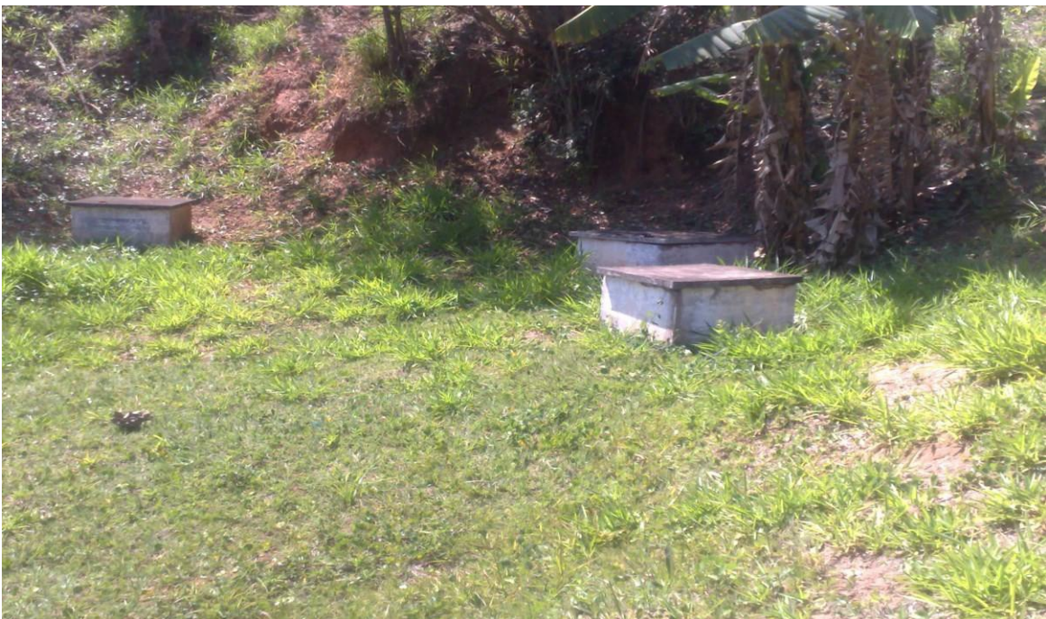
Foto: 30 – Visão externa das caixas de alvenaria, onde estão localizadas as minas de água (cada caixa representa uma mina).
