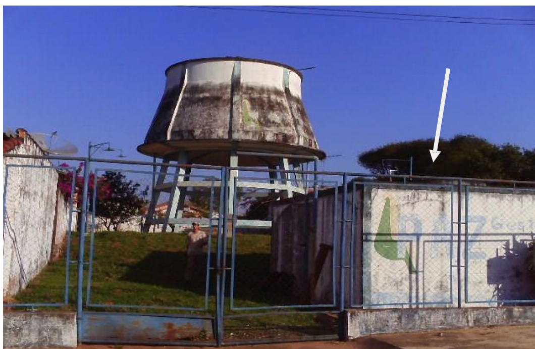
Foto: 07 – Reservatório Apoiado – Capacidade de 90m 3 - (Ver seta indicativa) Localização: Rua Manoel Francisco – Centro
