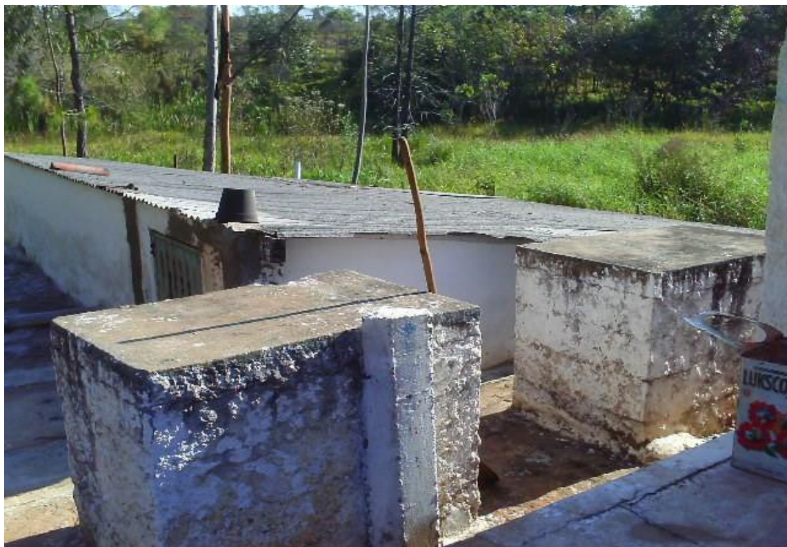
Foto: 24 –Reservatório semienterrado nº 2 – Capacidade 25m 3
