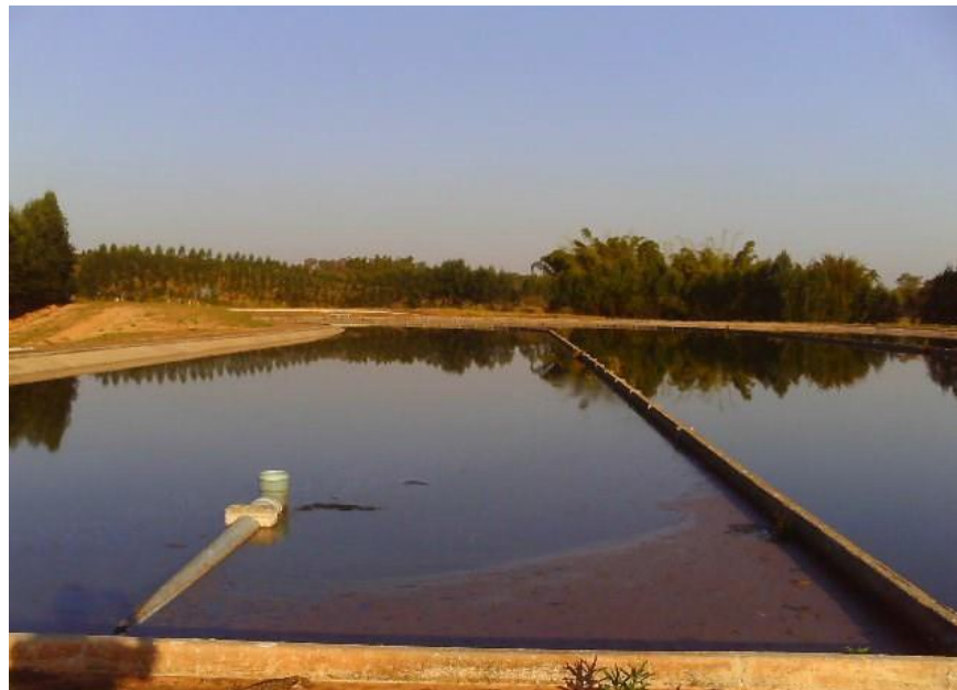
Foto: 57 - Visão-III - Vista parcial da 2ª lagoa de tratamento (facultativa)
