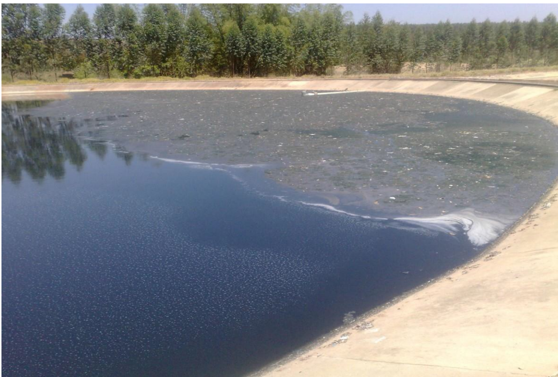
Foto: 54 - Visão III – Vista da Parte final da lagoa anaeróbia – (1ª lagoa)
