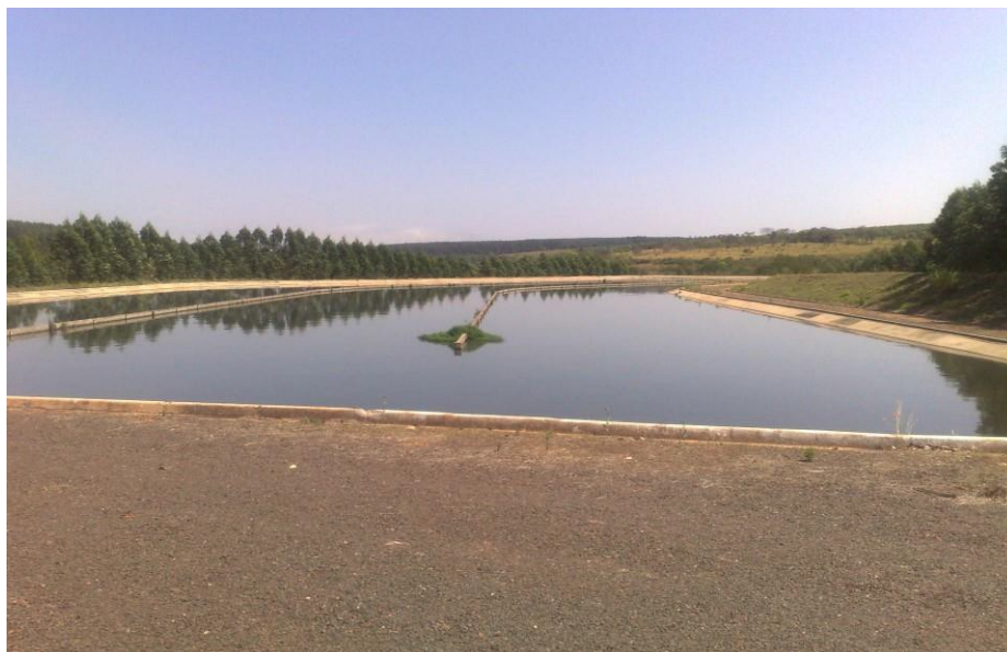
Foto: 56 - Visão-II – Vista parcial da 2ª lagoa (facultativa)
