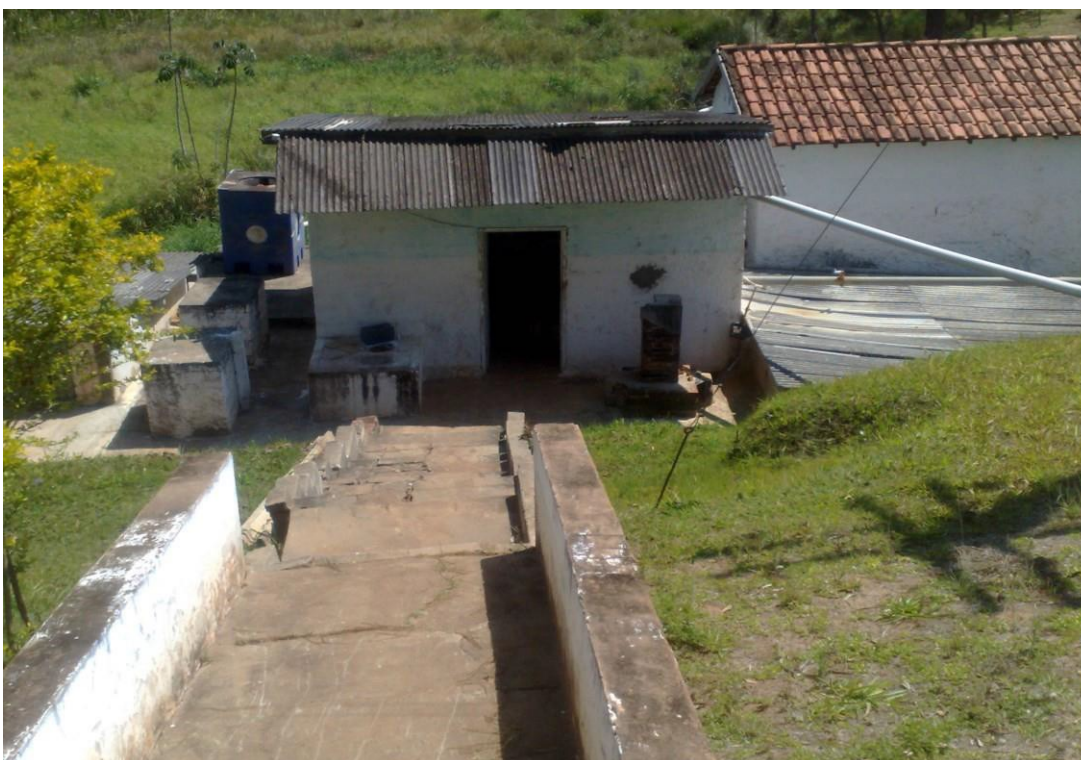
Foto: 26 – Vista frontal da casa das bombas
