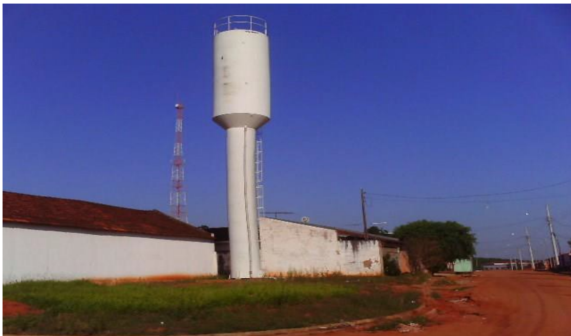
Foto: 09 - Reservatório do CDHU – Capacidade de 50m 3 - Localização: Rua Moisés Marques Albino esquina c/ Rua Antonio Consalter Longo.
