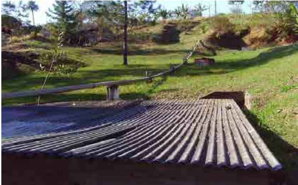
Foto: 23 – Reservatório semienterrado nº 1 – Capacidade de 25m 3 - Recebe água das minas, e após o tratamento é recalçada para os reservatórios da cidade.
