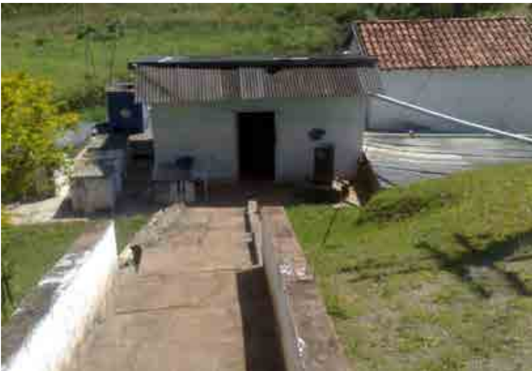
Foto: 26 – Vista frontal da casa das bombas
