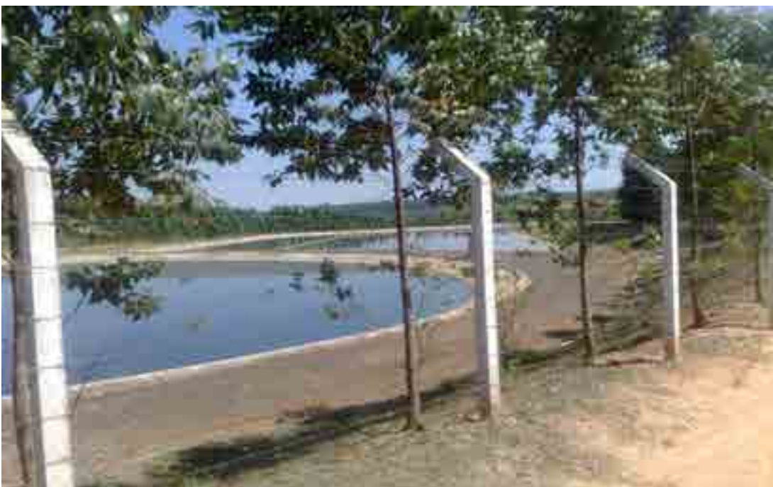
Foto: 60 - Visão externa do local onde se encontra a Estação de tratamento de Esgoto de Cabrália Paulista
