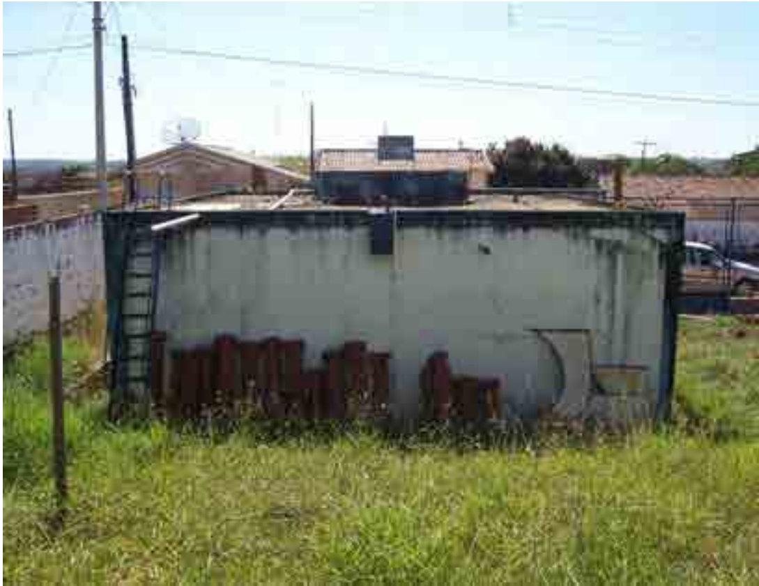
Foto: 08 – Reservatório Apoiado – Capacidade de 90m 3 - Localização: Rua Manoel Francisco – Centro
