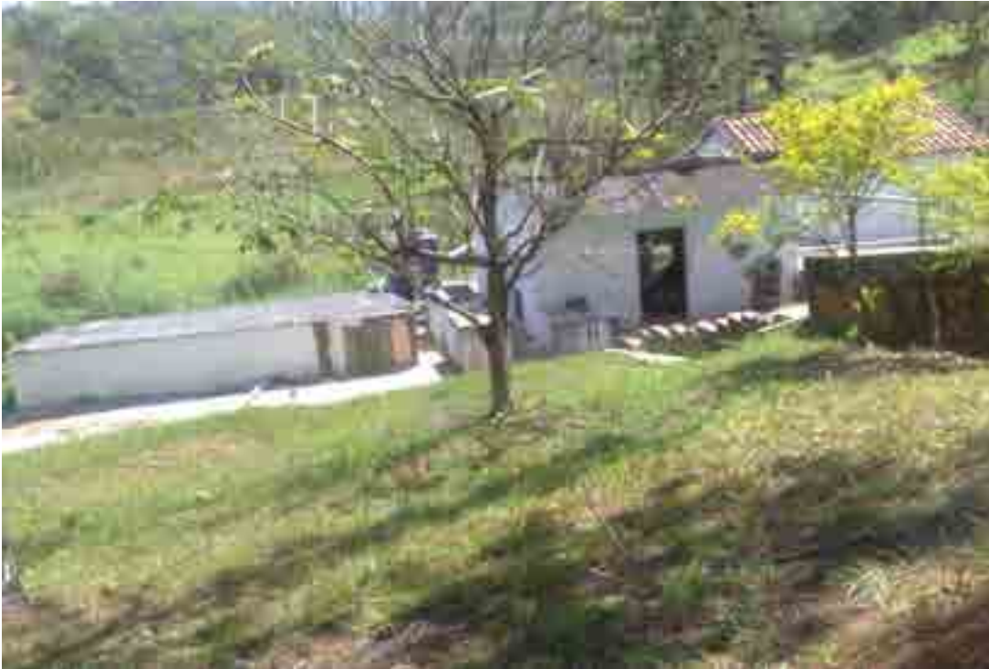
Foto: 25 – Visão externa da casas das bombas
