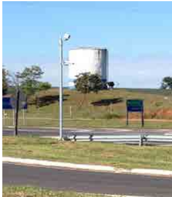
Foto: 12 – Ao fundo - Reservatório do Trevo – Capacidade 180m 3 - Localização: Trevo na entrada de Cabrália Paulista.
