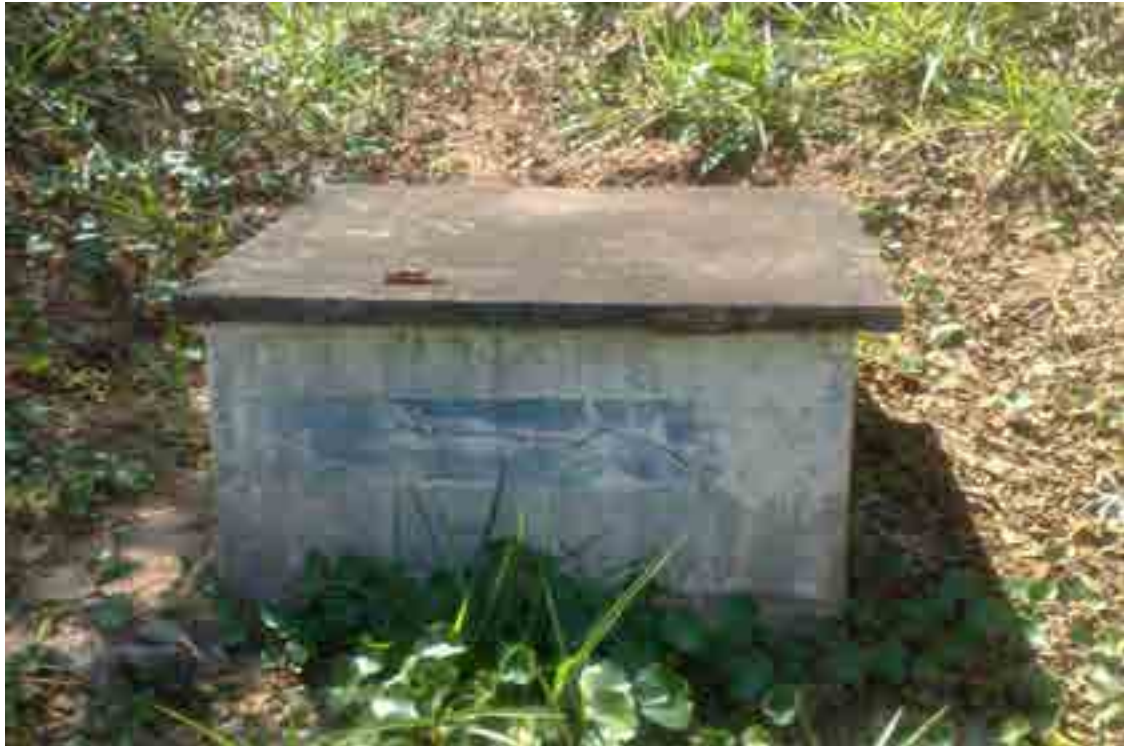
Foto: 31 – Visão externa da caixa de alvenaria, onde está localizada a mina de água
