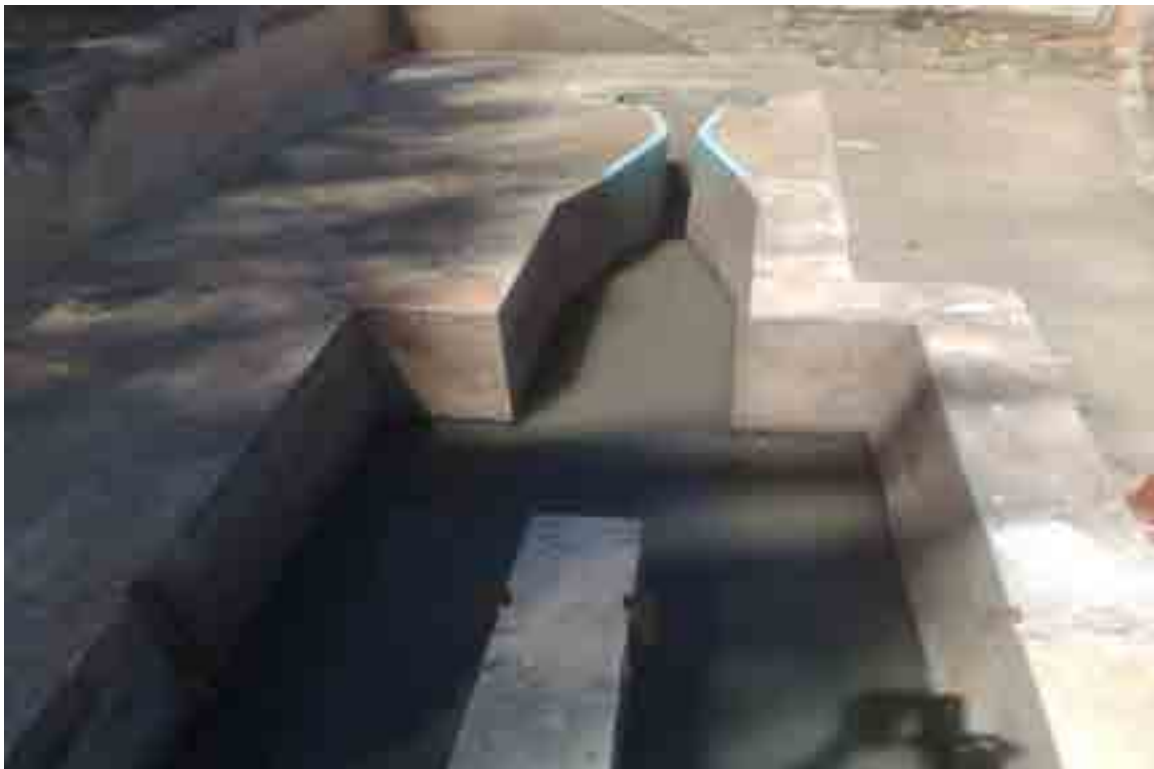
Foto: 51 - Calha Parshall
