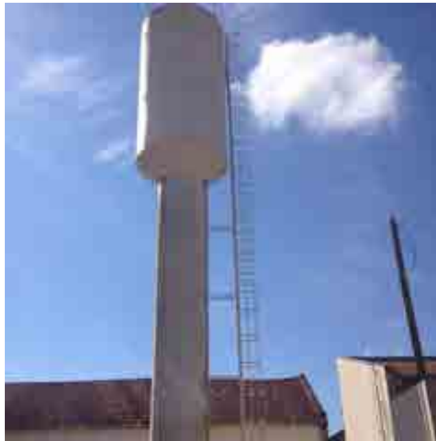
Foto: 10 – Reservatório do CDHU – Idem acima
