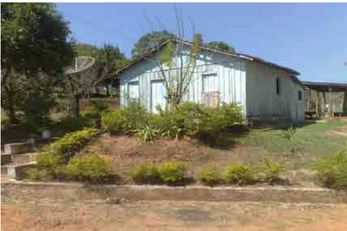
Foto: 44 – Vista Frontal da residência do operador(a) das bombas de recalque
