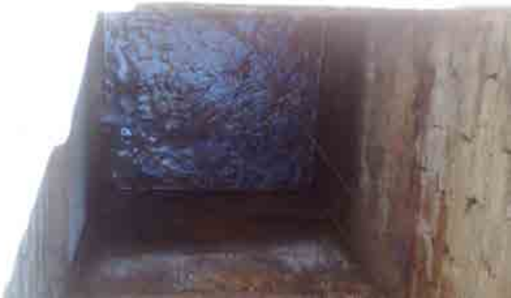
Foto: 33 – Visão interna de uma caixa de proteção, onde há uma mina de água em plena atividade.
