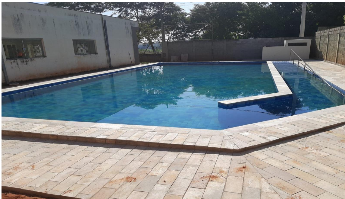
Foto Nº 02 - Vista posterior da piscina.
