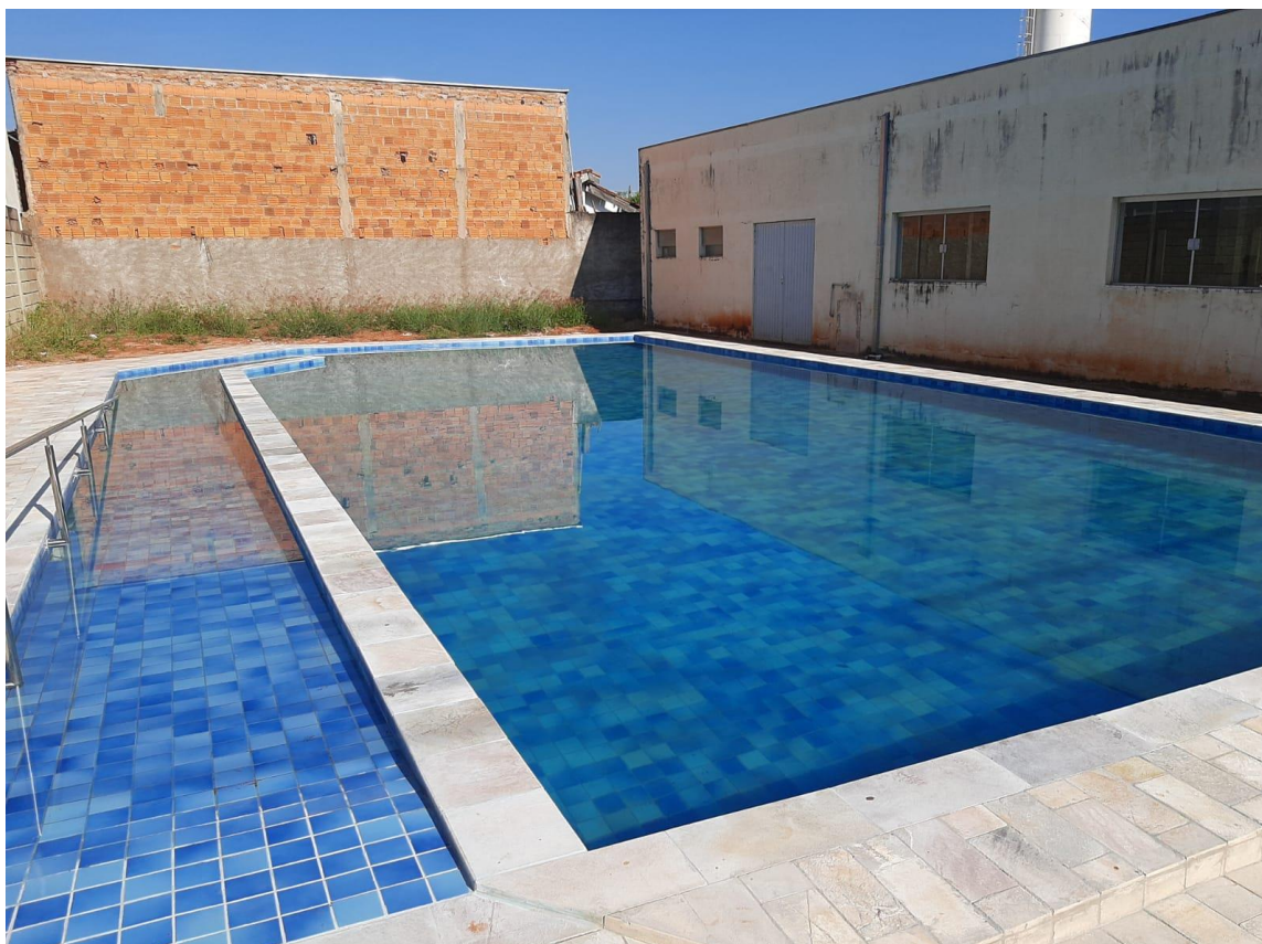
Foto N° 01 – Vista frontal da piscina.
