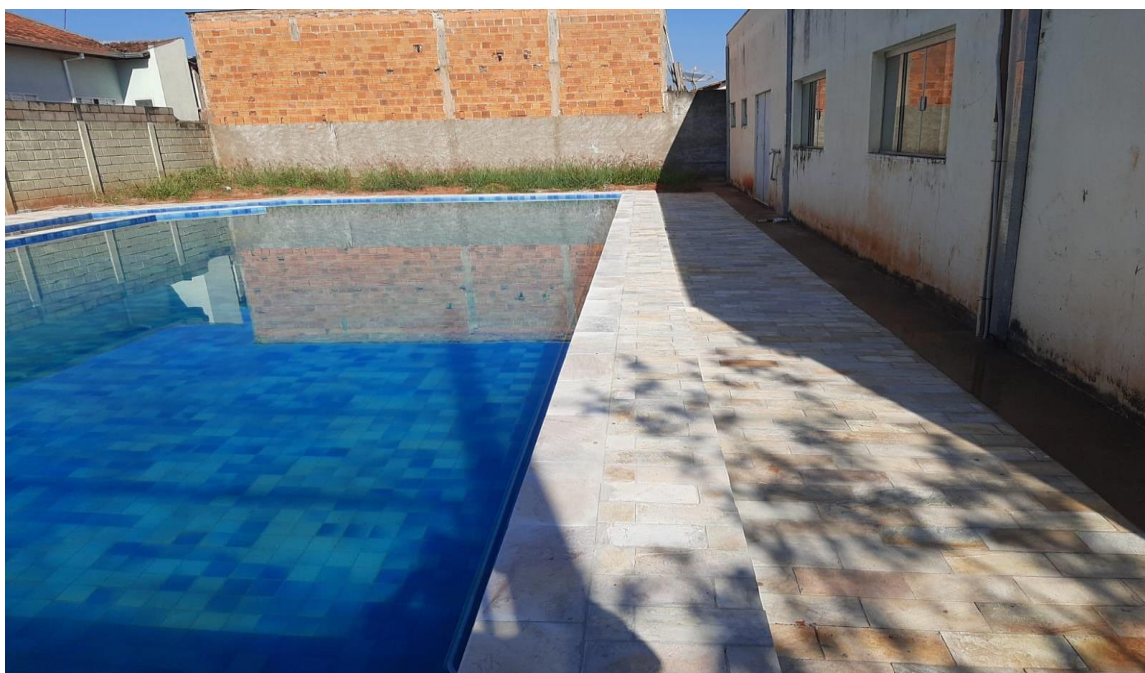
Foto Nº 03 - Mostra a lateral direita da piscina.
