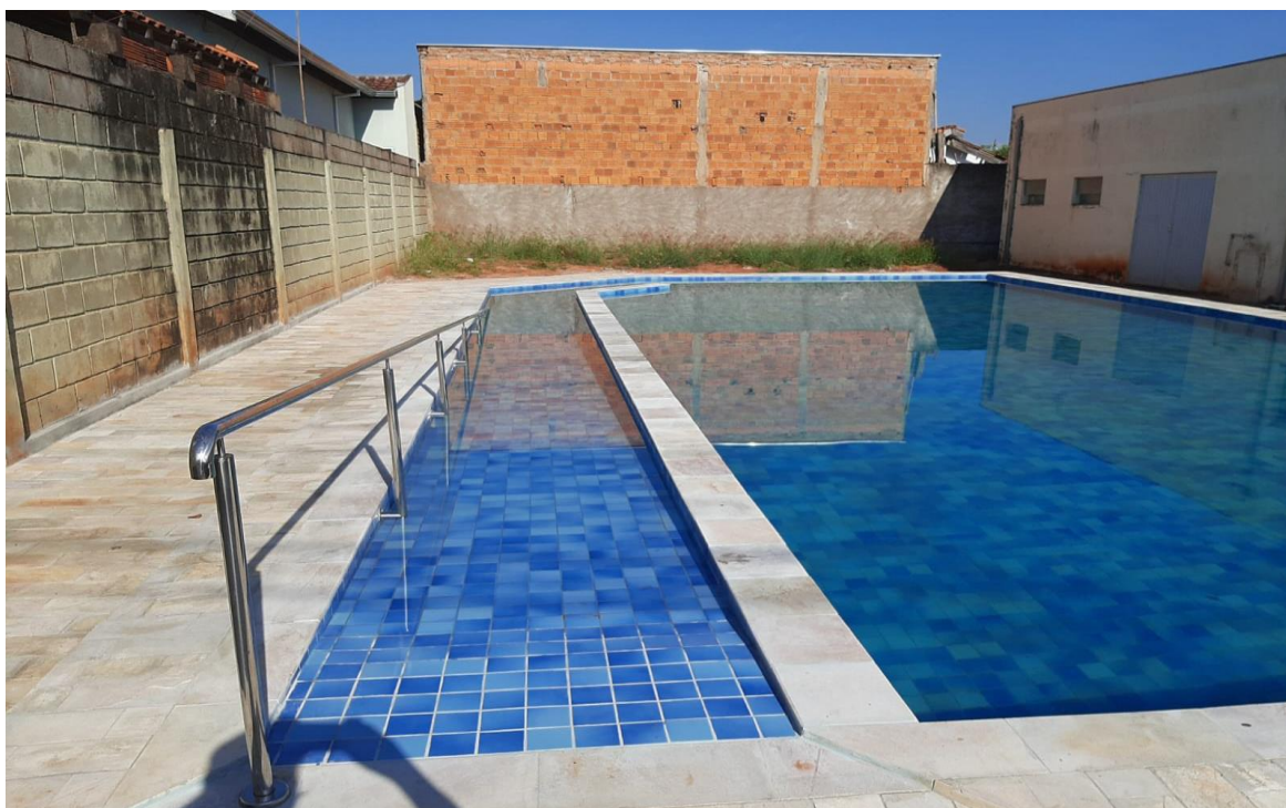
Foto Nº 05 - Mostra a rampa de acesso para cadeirante.
