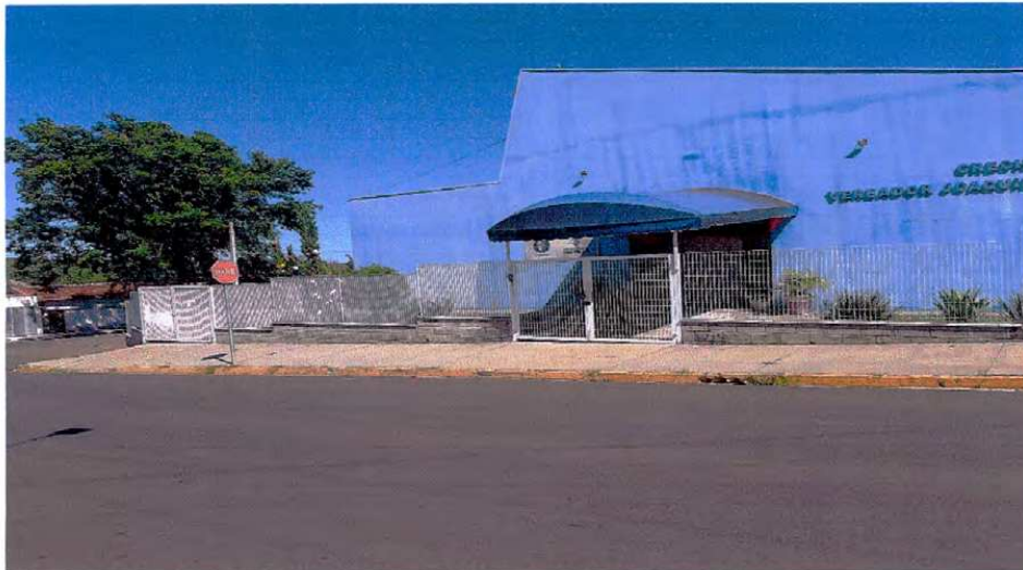
Foto Nº 01 – Mostra a fachada da Creche na Rua Benedito de Alemida Teixeira, Nº 1728
