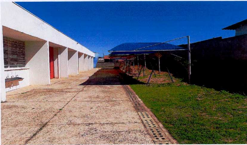
Foto N° 04- Mostra outra vista do local onde será feita a Ampliação da Creche
